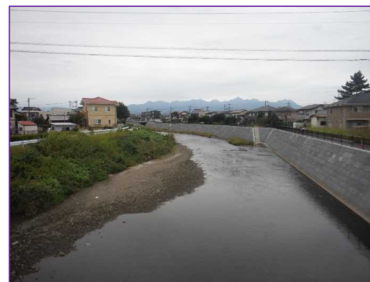
写真 井野川整備状況 (護岸工、築堤工)
