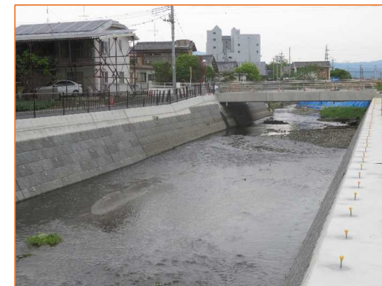
写真 大川整備状況(護岸工、築堤)
