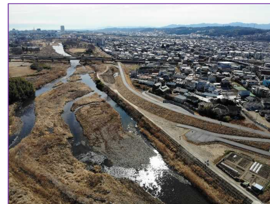
写真 烏川整備状況 (護岸工、築堤工)
