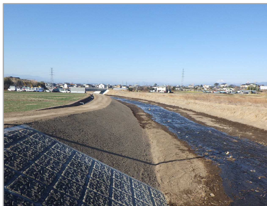
写真 寺沢川整備状況（河道拡幅、築堤工、橋梁掛替）
