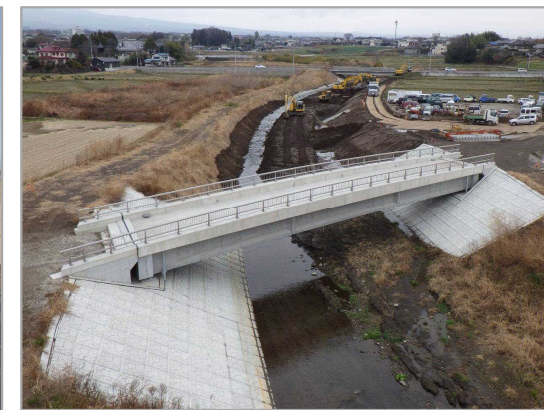
写真 寺沢川整備状況（河道拡幅、築堤工、橋梁掛替）
