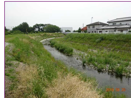
写真 温井川整備状況（護岸工）
