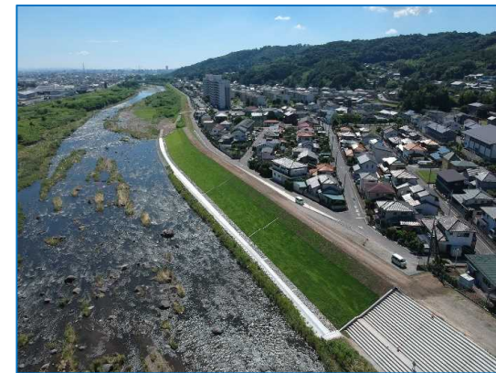
写真 碓氷川整備状況（護岸工、築堤工）
