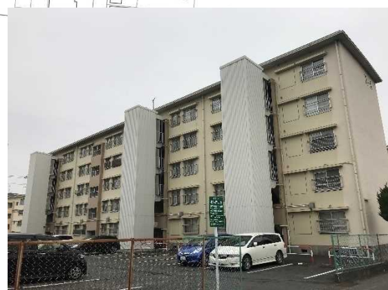
エレベーター増設住棟
