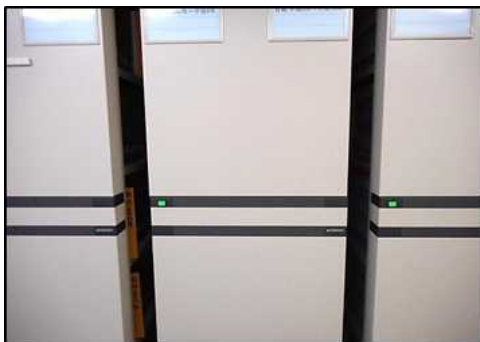
(写真1) 新館書庫 書庫の隙間
