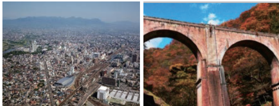
上空から見た高崎駅周辺【高崎市提供】 碓氷第三橋梁(めがね橋)【(一社)安中市観光機構提供】
