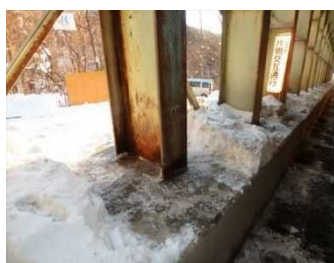
鋼材の腐食
