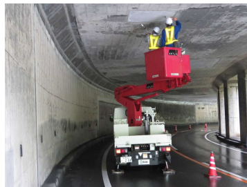
防雪施設点検
