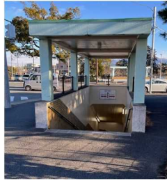
(主)前橋安中富岡線 中央地下歩道
