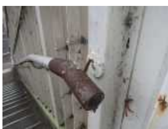
手摺りの破断
