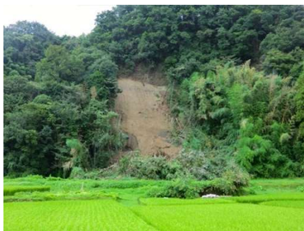
崩落した竹林
