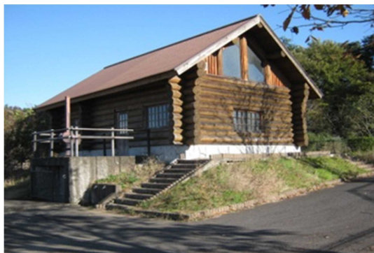
図 4.27 浄化揚水ポンプ場
