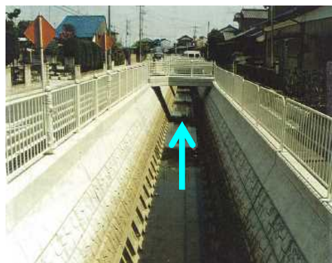
下流部は用地買収が困難なため、コンクリートブロックで護岸を整備し流下能力を確保しました
