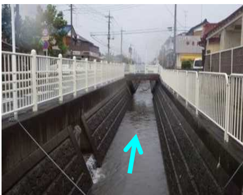
下流部は用地買収が困難なため、コンクリートブロックで護岸を整備し流下能力を確保しました
