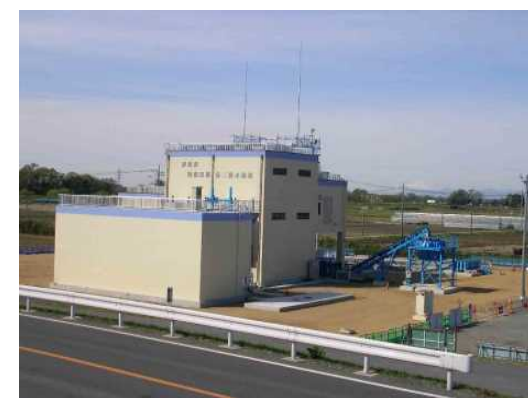
邑楽東部第二排水機場の整備状況
