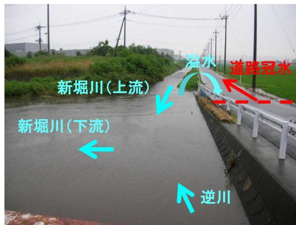
新堀川・逆川合流点の浸水状況 (平成23年7月台風6号)
