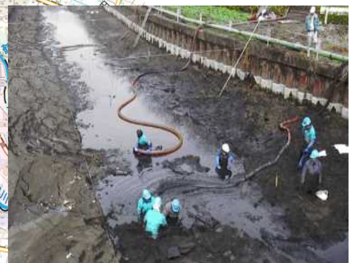
パキュームによる底泥浚渫
