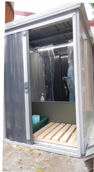
《前室》 物置に扉を追加して設置した例。
