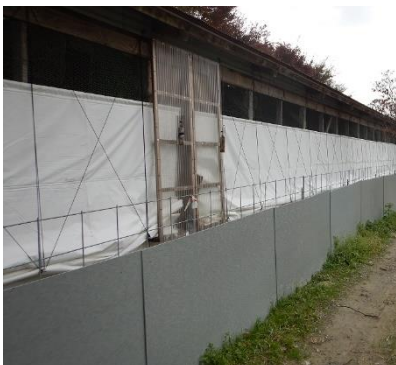
既存の野生動物対策メッシュ柵に追加で板を設置した例。
