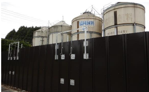
タンクにヒモを設置し、衛生管理区域外から開閉できるようにした例。
