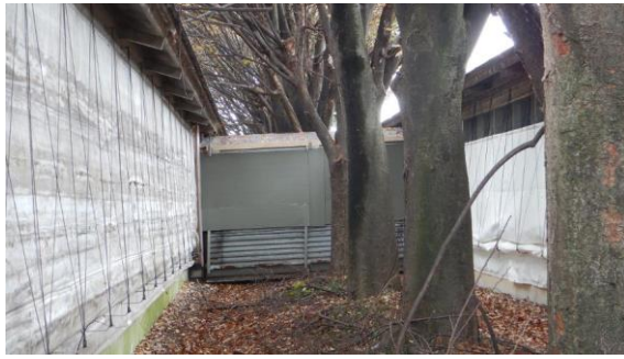
《豚舎間通路》 もとからあった通路に再生プラスチック板の壁と、 透明波板の屋根を設置した例。 上：外から見た通路 右：中から見た通路
