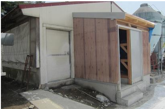
《前室》 基礎の上に木造で建築した例。
