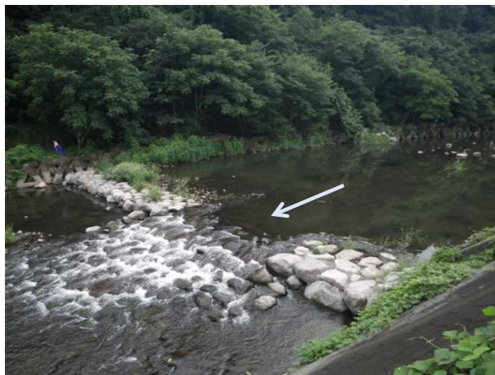
図 4.24 対策のイメージ（床固め工）
