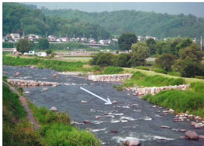
図 4.25 対策のイメージ（水制工）
