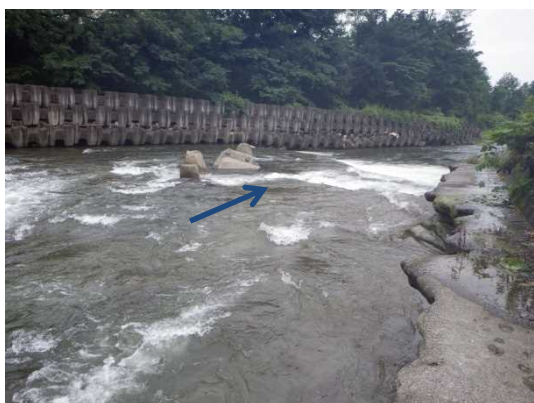
図 2.5 河床洗掘箇所
