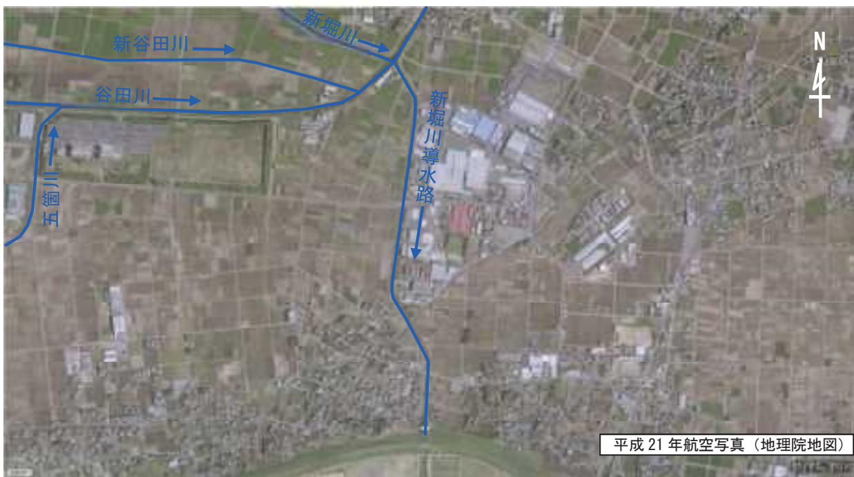
図 4.13 航空写真(新堀川導水路)
