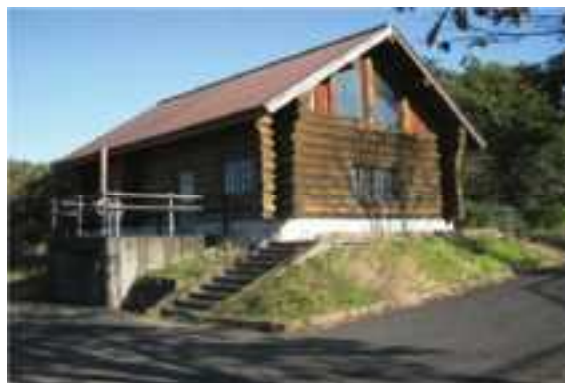
図 4.27 浄化揚水ポンプ場
