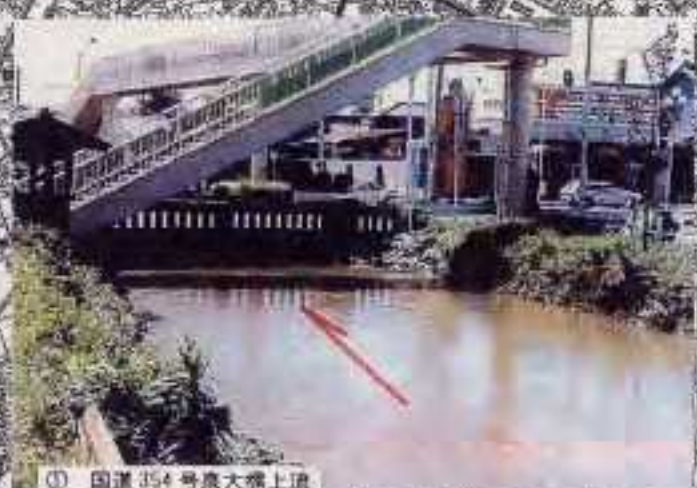
① 国道354号東大橋上流
