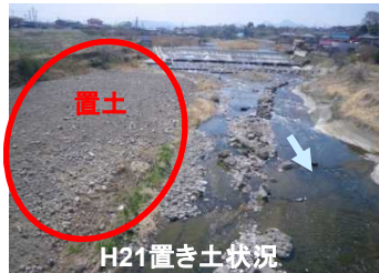
時間の経過とともに土砂が流出
