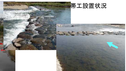
帯工上流に砂礫が堆積
