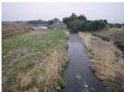
河床に土砂が堆積し断面を阻害
