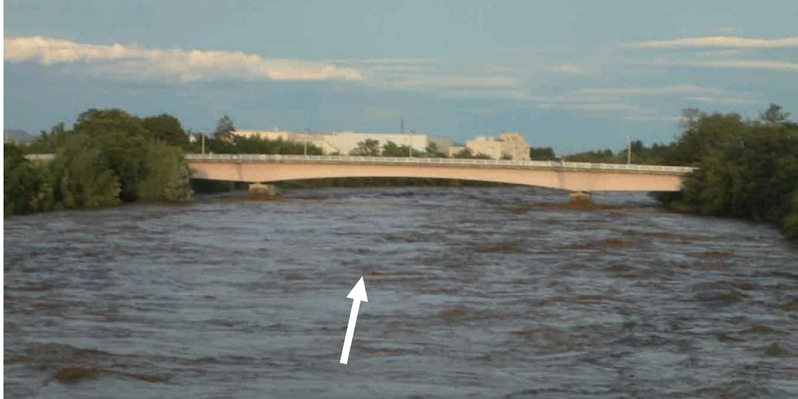
利根川(玉村大橋上流) 出水状況 (玉村町)
