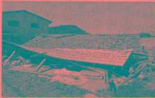
強風で変形した屋根の10年ほど経った新築一戸建て。後日調査員、みどり町宮原町宮原町。撮影
