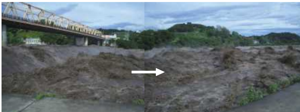
利根川(坂東橋下流) 出水状況 (渋川市)
