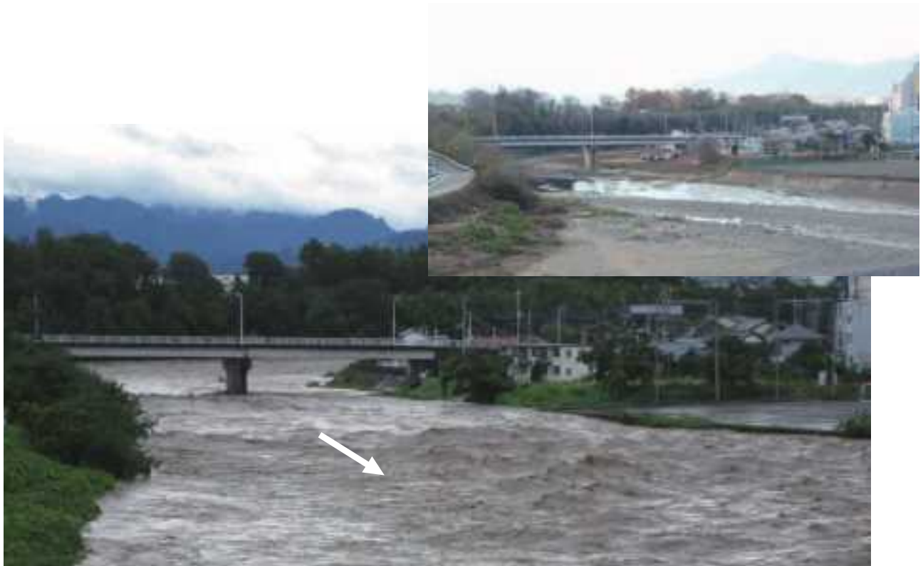
鍬川(鍬橋下流) 出水状況 (富岡市)
