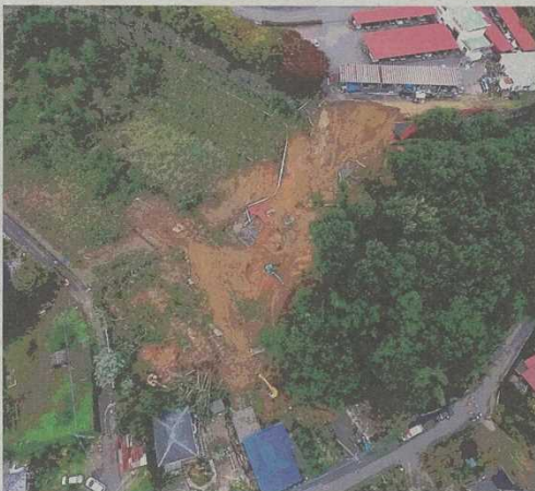
ドローンで撮影した土砂崩れの現場(24日読者提供)
