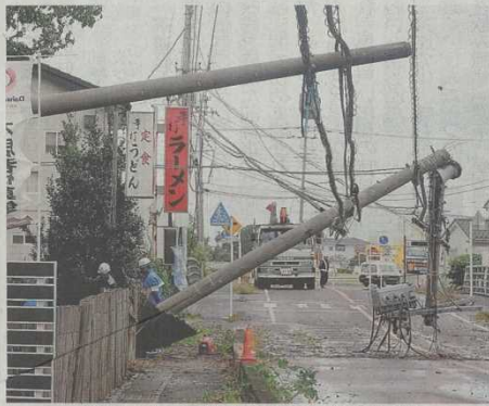
倒木によって折れた電柱＝23日午前8時ごろ、館林市堀工町
