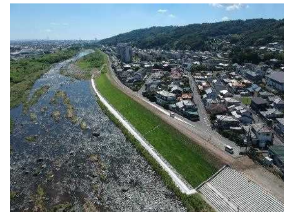
河川改修（碓氷川）
