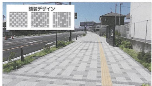
写真2 織物を意識したインターロッキング舗装 (都)コンベンション施設北口線 高崎市内)
