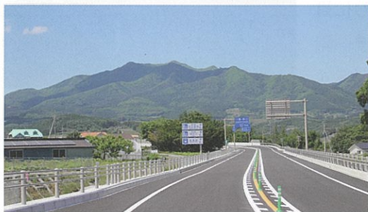
写真1 道路付属物の色彩統一や無電柱化の実施 (上信自動車道(金井バイパス) 渋川市内)
