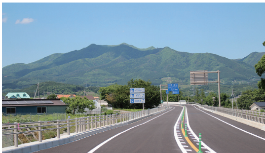
写真1 道路附属物の色彩統一や無電柱化の実施 (上信自動車道(金井バイパス) 渋川市内)
