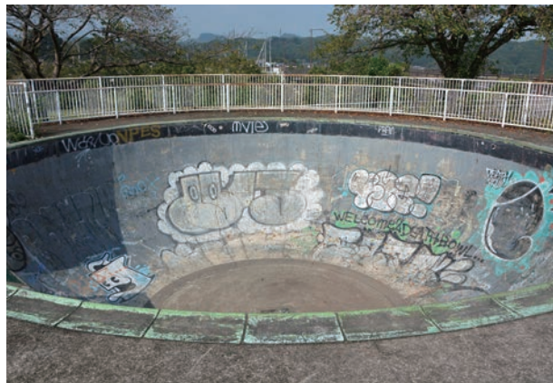
米山公園サーキット場の通称『デスボウル』
