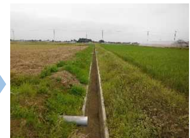
排水路(整備後)
