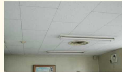
その他の石綿含有建材 (レベル3)
