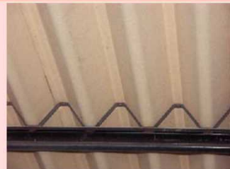
石綿含有保温材、断熱材、耐火被覆材 (レベル2)
