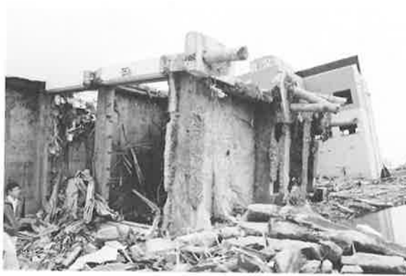
土台ごと横倒しになった建物（女川町中心部）
