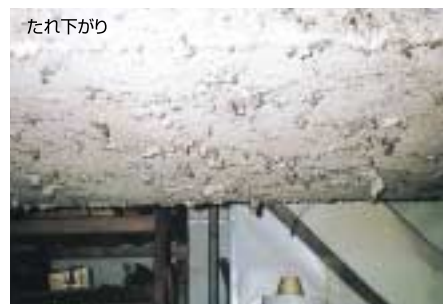
局部的損傷・欠損
