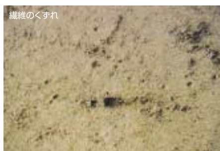
局部的損傷・欠損
