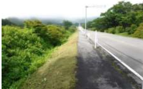
道路の除草状況（渋川松井田線）
