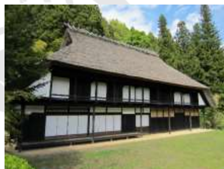
富沢家住宅（画像提供：中之条町）
