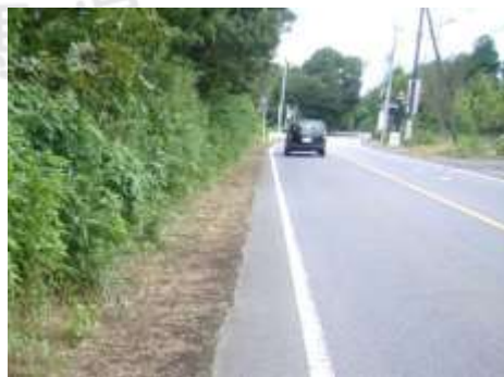
道路の除草状況（前橋赤城線）
