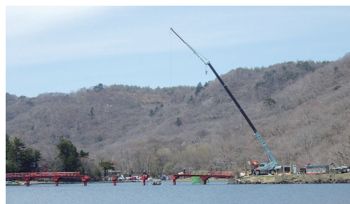
写真4：撤去中の啄木鳥橋
