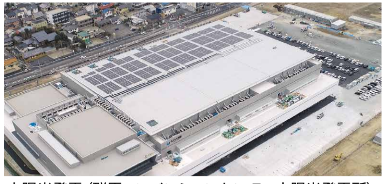
太陽光発電(群馬コンベンションセンター太陽光発電所) 年間約60万kWhの電力を供給しています。一般家庭約160軒分の年間消費電力に当たります。
