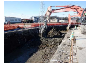
対策工事を実施した藤川用水地区
