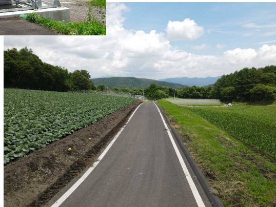
整備をした農道 (仙之入地区)
