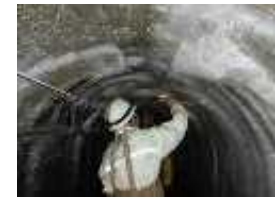
追貝平1期地区劣化状況
