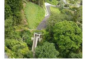
完成状況 (美野原2期地区)
