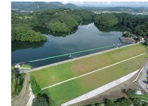
堤体下流側の耐震補強工事が完了した大谷池
