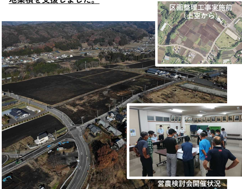
上宿原地区における区画整理工事の完了状況
