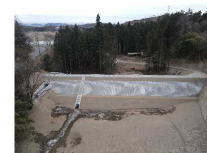
豪雨・地震対策工事が完成した奥沢下沼
