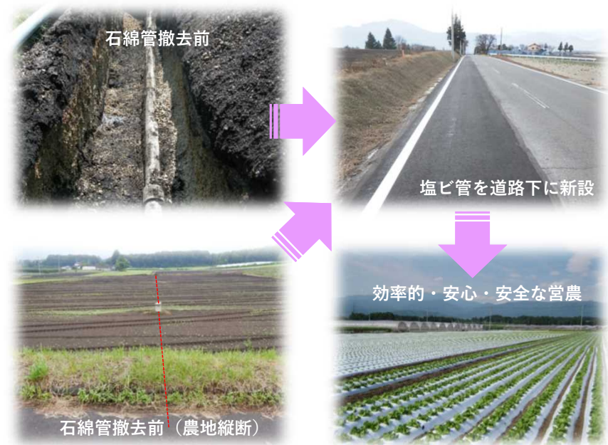
赤城原地区における石綿セメント管の撤去状況
