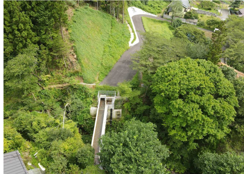
改修を終えた隧道と掛樋と管理道路
