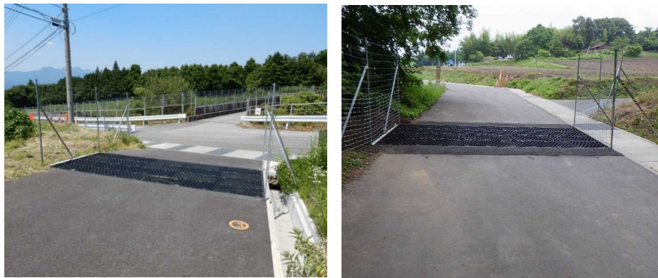
中原地区における粗目グレーチングの設置状況
