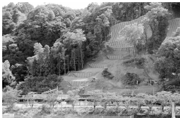
土留工、法枠工による山腹崩壊の復旧
