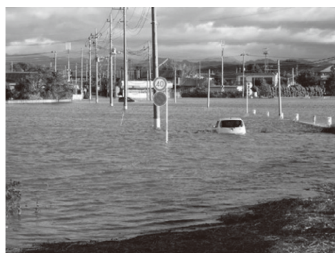
令和元年東日本台風（台風第19号）の被害 石田川（太田市）
